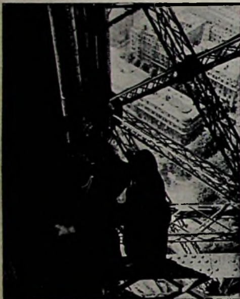
De coaxiale kabel wordt aan de stalen binten van den Eiffeltoren bevestigd.
